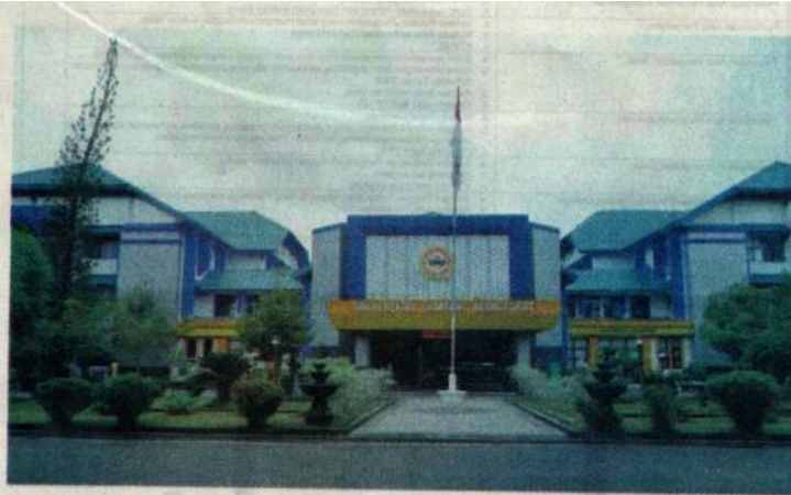
PRESTASI: Gedung Rektorat Universitas Lambung Mangkurat (ULM) di Banjarmasin mencatatkan skor SINTA tertinggi di Kalimantan dan masuk 30 besar EduRank nasional.
